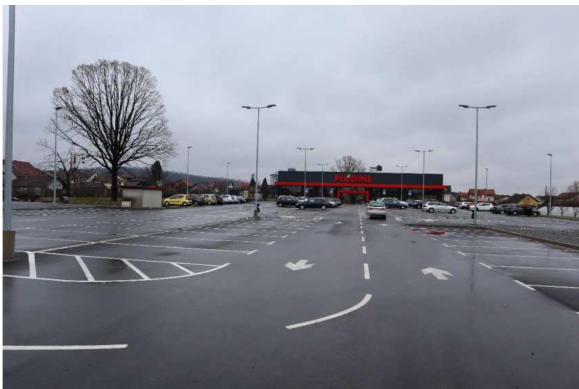
Slika 99 Parkiralište u sklopu trgovine (Autor: 3E PROJEKTI d.o.o.)
