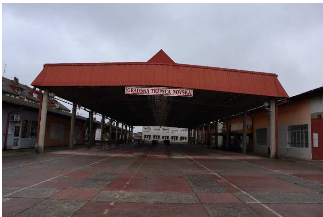
Slika 26 Pogled na pročelje tržnice (Autor: 3E PROJEKTI d.o.o.)
