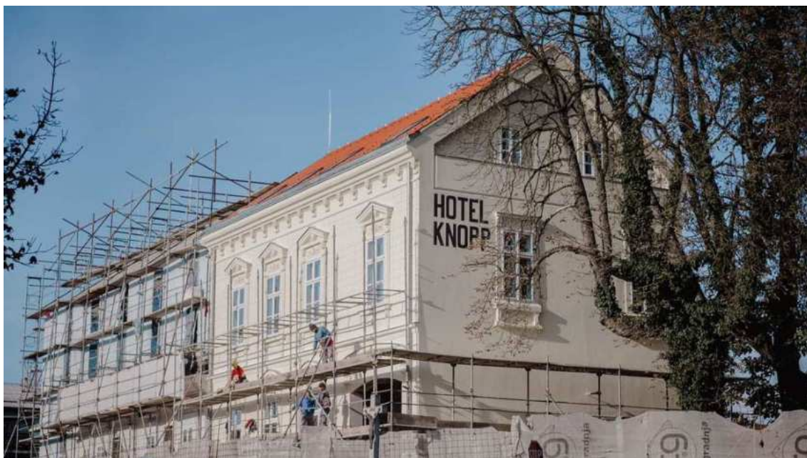
Slika 109 - Radovi na rekonstrukciji i prenamjeni zgrade hotela Knopp (Izvor: www.lokalni.vecernji.hr )
