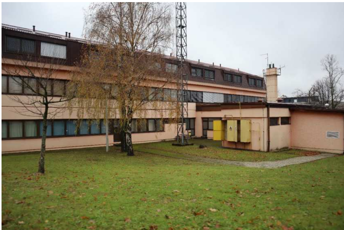
Slika 122 – Učenički dom u Novskoj – postojeće stanje (Autor: 3E PROJEKTI d.o.o.)
