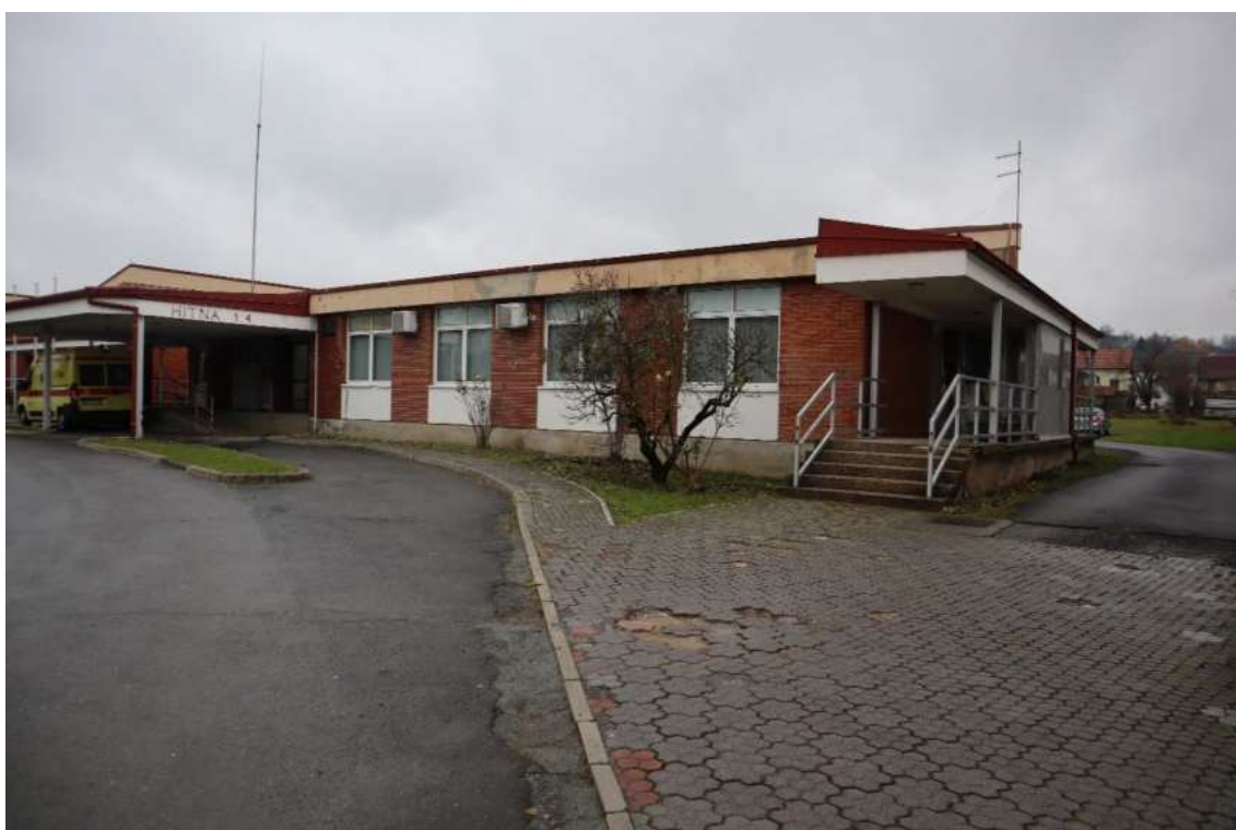
Slika 50 Prostori oko Doma zdravlja, dnevni centar za starije osebe (Autori: 3E PROJEKTI d.o.o. i Andlar)
