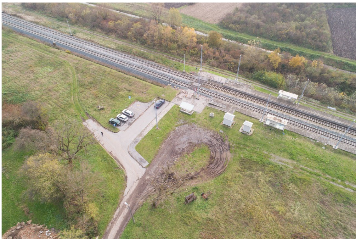
Slika 97 Koridor željezničke i postaja Rajići (Autori: 3E PROJEKTI d.o.o. i Andlar)
