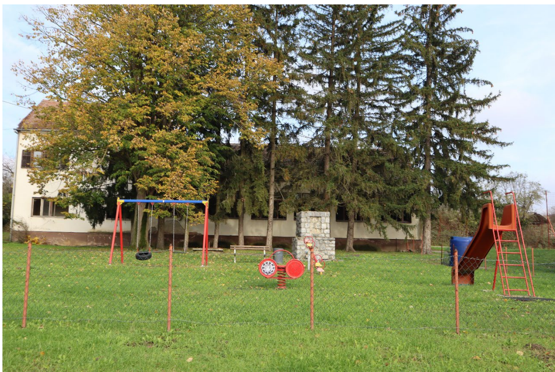
Slika 116 – Nekadašnja škola u Borovcu – postojeće stanje (Autor: 3E PROJEKTI d.o.o.)
