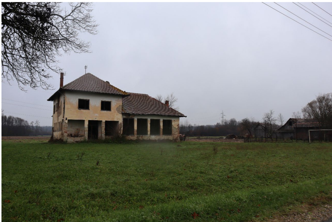
Slika 115 – Nekadašnja škola u Sigecu – postojeće stanje (Autor: 3E PROJEKTI d.o.o.)
