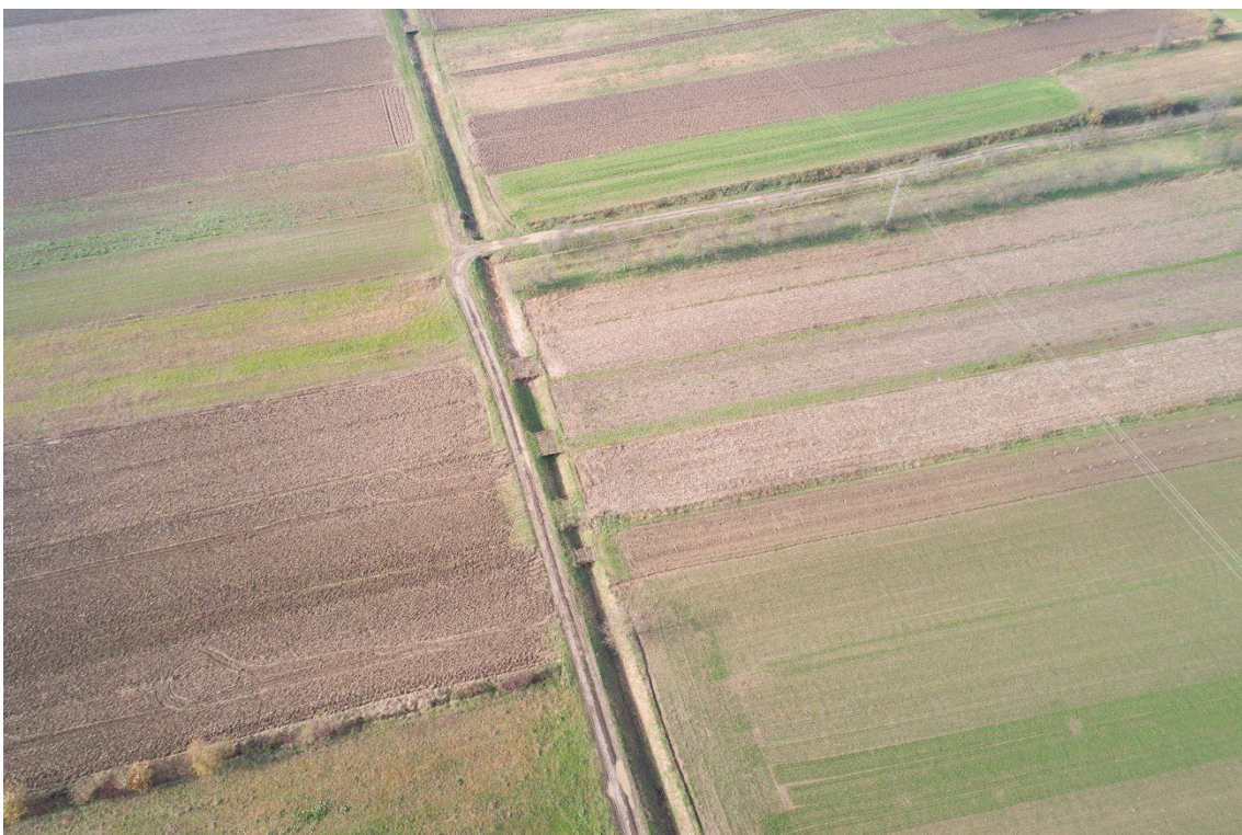
Slika 15 Melioracijski kanali unutar poljoprivrednih površina (Autori: 3E PROJEKTI d.o.o. i Andlar)
