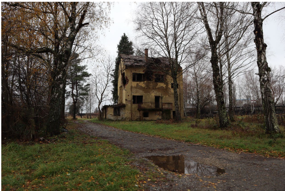
Slika 117 – Nekadašnja ložionica HŽ-a, Novska – postojeće stanje (Autor: 3E PROJEKTI d.o.o.)
