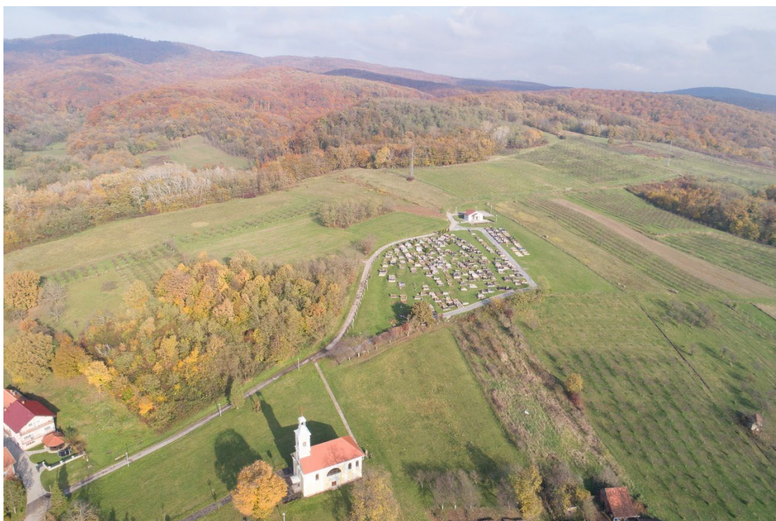
Slika 41 Groblje i crkva u Roždaniku (Autori: 3 E PROJEKTI d.o.o. i Andlar)
